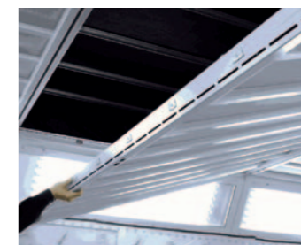
Hinged ceiling filter frames for easy filter replacement. Posibilidad de apertura y sustitución del filtro de techo.
